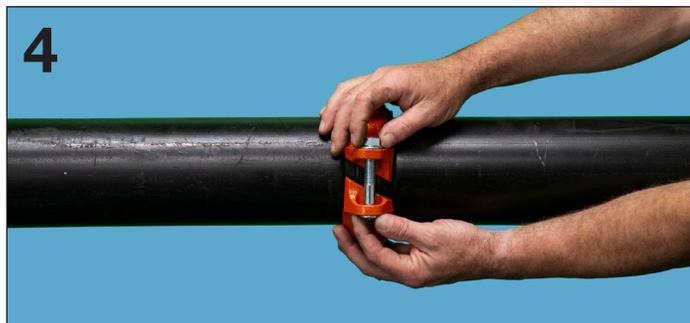
**4.** Afrouxe a porca restante (para apoio angular) para permitir que o conjunto de acoplamento gire em torno do tubo e da junta.
