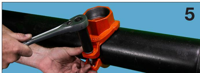
**5.** Aperte todas as porcas em quantidades iguais enquanto alterna entre todas as porcas. Apertar uniformemente as porcas enquanto as alterna é importante para evitar a compressão da junta e garantir o encaixe e a vedação adequados do conjunto do tee mecânico em tubos. Isso é necessário para ferramentas manuais e de impacto.
