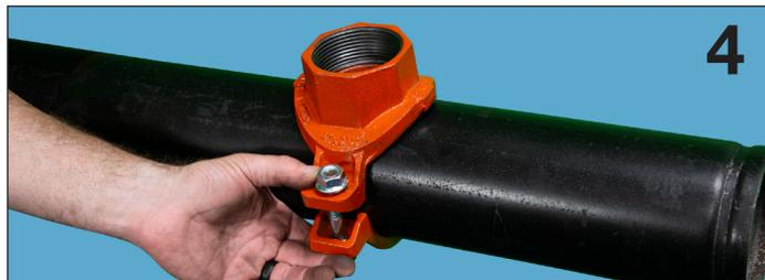
**4.** Insira o parafuso em U (para 041) ou alinhe o compartimento da correia do Tee mecânico (MTT ou MTG) com o compartimento de saída e instale os fixadores manualmente para manter o conjunto do Tee mecânico no lugar no tubo.
