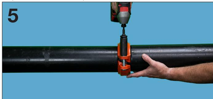
**5.** Aperte todas as porcas em quantidades iguais enquanto alterna entre todas as porcas. Apertar uniformemente as porcas enquanto se alterna é importante para evitar a compressão da junta e garantir o encaixe e a vedação adequados do conjunto do acoplamento em tubos e conexões. Isso é necessário para ferramentas manuais e de impacto.
