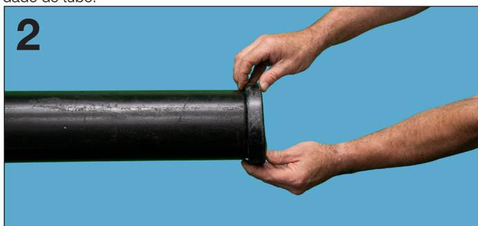
**2.** Instale a junta totalmente sobre a extremidade do tubo para que a borda da junta não fique saliente. É necessário algum alongamento da junta para caber no tubo. Se não for necessário alongamento, verifique se todo o equipamento é do tamanho correto.
