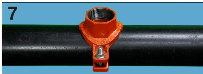
**7.** Inspeção visualmente todos os componentes do Tee mecânico para garantir que ele esteja instalado corretamente no tubo.
