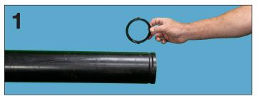
1. Desmonte la Tee mecánica e inspeccione la junta para asegurarse de que no esté dañada y sea adecuada para el servicio previsto. Inspeccione la tubería donde se pretende instalar la Tee mecánica, asegurándose de que sea redonda y no tenga ningún daño en la tubería que pueda afectar el sellado de la junta.
