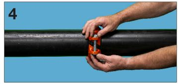
**4.** Afloje la tuerca restante (para la almohadilla angular) para permitir que el conjunto del acoplamiento oscile alrededor del tubo y la junta.
