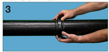
**3.** Alinee y posicione los extremos de los tubos correspondientes. Deslice la junta en su posición centrada entre las ranuras en cada extremo de la tubería. Ambos surcos deben ser visibles.
