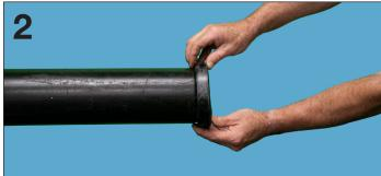
2. Instale la junta completamente sobre el extremo del tubo de manera que el borde de la junta no sobresalga. Es necesario estirar un poco la junta para que encaje en la tubería. Si no se requiere estirar, verifique que todo el equipo sea del tamaño correcto.
