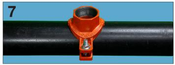
7. Inspeccione visualmente todos los componentes de la Tee mecánica para asegurarse de que esté instalada correctamente en la tubería.
