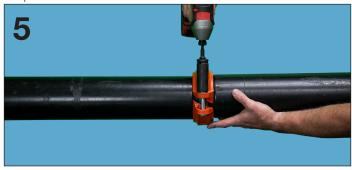
**5.** Apriete todas las tuercas en cantidades iguales mientras alterna entre todas las tuercas. Es importante apretar las tuercas de manera uniforme mientras se alterna el apriete de la tuerca para evitar que la junta se pellizque y asegurar un ajuste y sellado adecuados del conjunto de acoplamiento en tuberías y accesorios. Esto es necesario tanto para herramientas manuales como de impacto.
